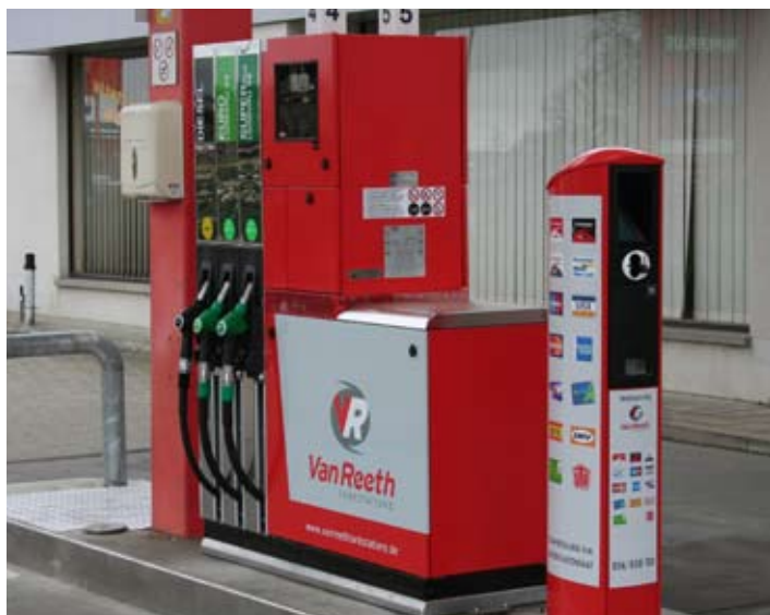
Une station-service Van Reeth équipée de distributeurs Quantum 510 avec terminal de paiement Crypto VGA Slimouth, capable de se connecter à différents distributeurs sur le même site.
